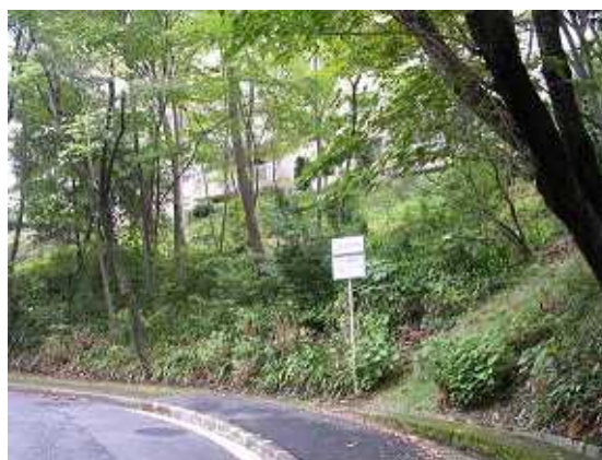
藪化した北進入路の法面（8号棟北側）
