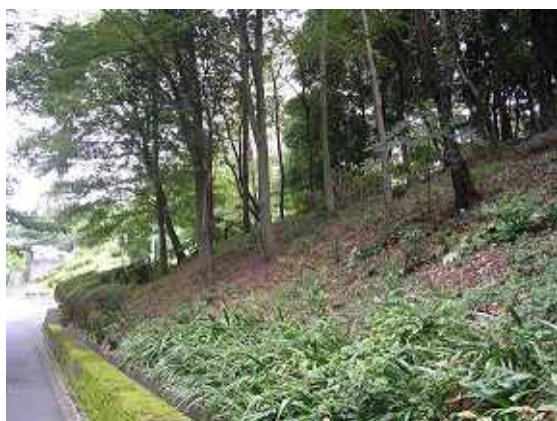
藪払いの済んだ法面北東角（D - B間）
