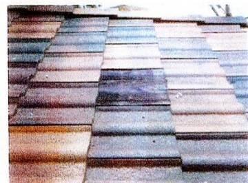
補修状況(イージーフラッシュプラス)
